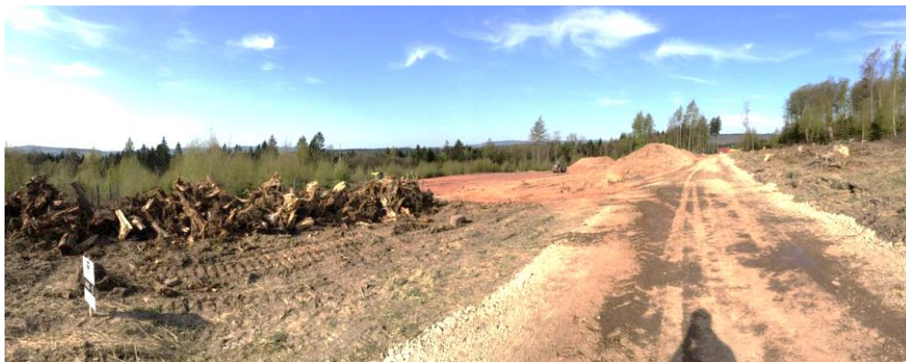
Abbildung 24: Windkraftbaustelle im Naturpark Kaufunger Wald (Hessen, 2016)
